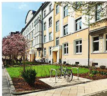
Alte Gebäude, neue Ansprüche. Der Althoffblock in Dortmund wurde saniert.
